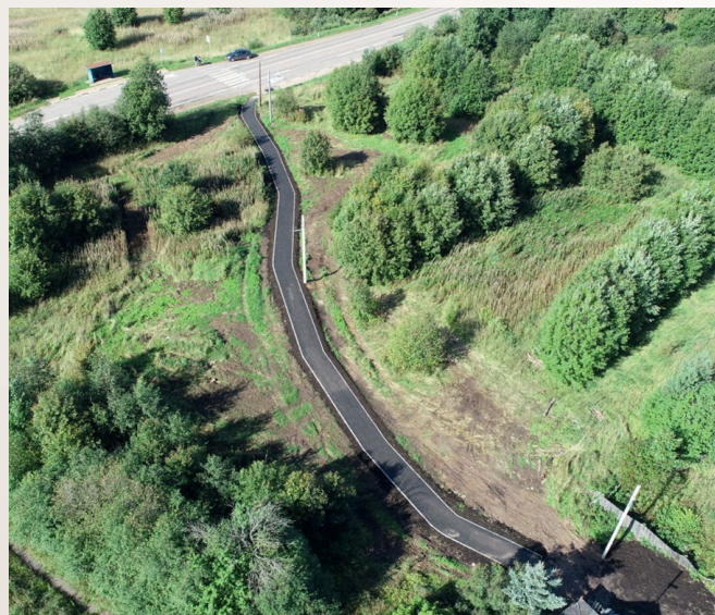
После выполнения работ
