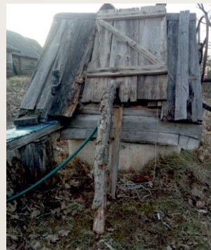
До выполнения работ
