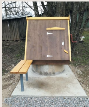
После выполнения работ
