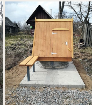
После выполнения работ
