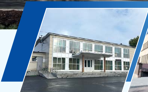
Дом культуры в дер. Бегуницы после капитального ремонта (Волосовский район)
