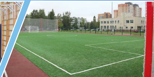
Спортивная площадка Кировской средней общеобразовательной школы № 2 после капитального ремонта (Кировский район)
