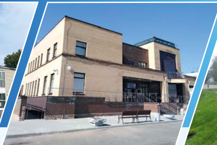
Строительство дома культуры со зрительным залом на 150 мест в пос. Новоселье (Ломоносовский район)
