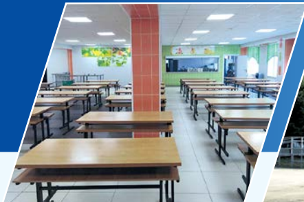
Волосовская средняя общеобразовательная школа №1 после капитального ремонта (Волосовский район)
