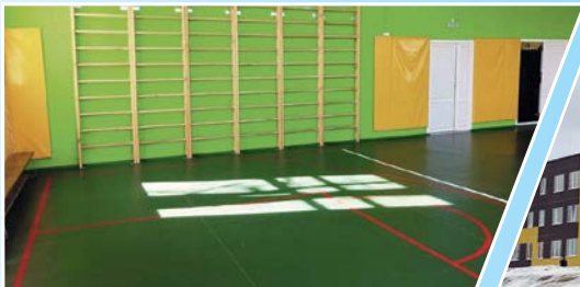
Спортивный зал Трубникоборской средней общеобразовательной школы после капитального ремонта (Тосненский район)
