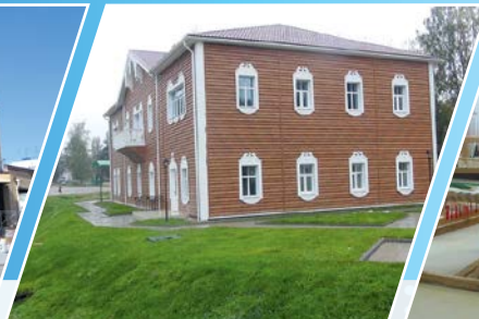
Строительство Веппского центра фольклора и ремесел в с. Винницы (Подпорожский район)
