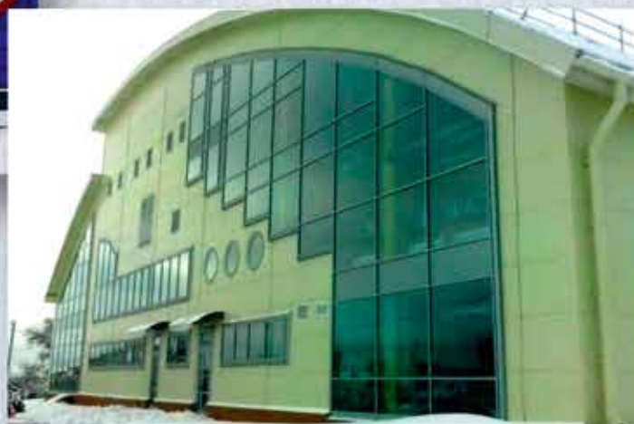
Строительство крытого катка с искусственным льдом в дер.Старая, Всеволожский район
