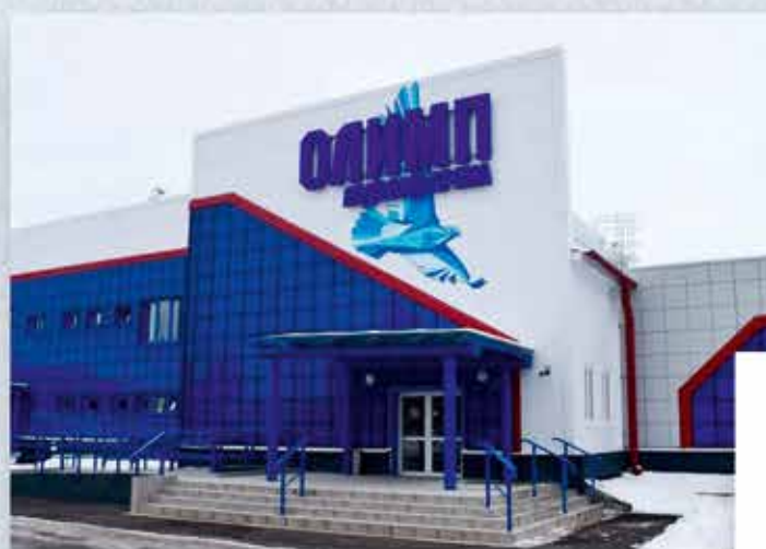
Строительство ледовой арены в г.Кингисепп
