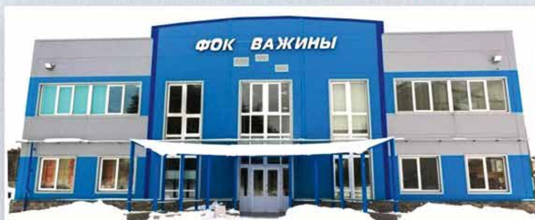
Строительство ФОКа в пос.Важины, Подпорожский район
