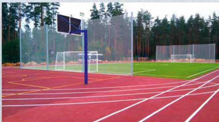
Капитальный ремонт спортивной площадки в п.Царицино озеро, Тихвинское г.п.
