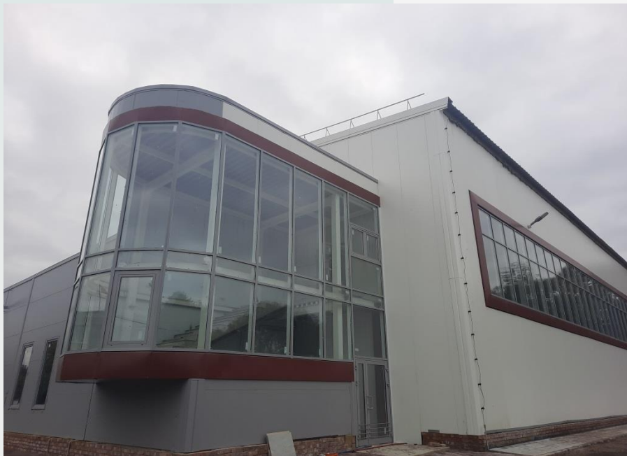
ФОК в г. Каменногорск, Выборгский район
