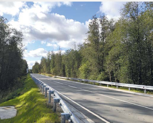
Капитальный ремонт дороги Менюши–Заручевье–Каменец, 18 км
