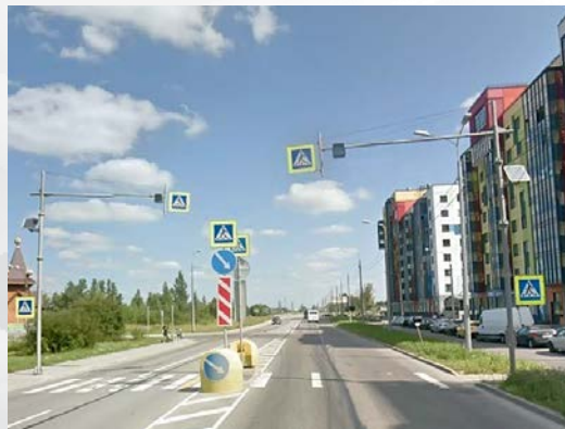
Реконструкция Красное село–Гатчина–Павловск, 3,321 км
