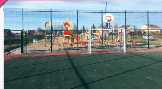
Строительство универсальной спортивной площадки в д. Истинка Гатчинского района
