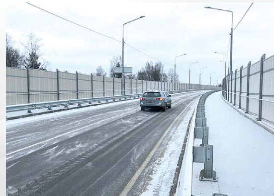
Путепровод Выборг–Каменогорск, ПК105+00, ПК 106+38,3
