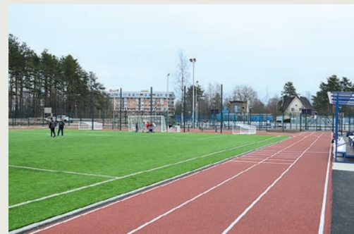
Спортплощадка в Токсово после реконструкции
