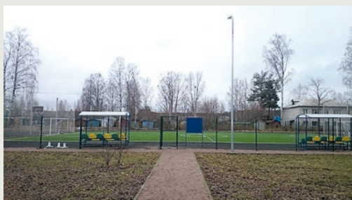
Спортивная площадка МОУ «Средняя общеобразовательная школа «Рахгунский центр образования» после капитального ремонта
