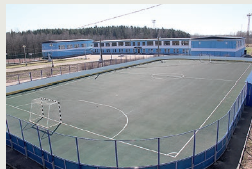
Спортивный комплекс в г.Бокситогорске после капитального ремонта
