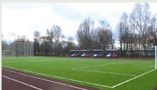
Стадион при Приморской специальной коррекционной школе-интернате после капитального ремонта
