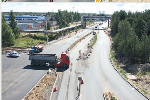
Копорское шоссе после реконструкции
