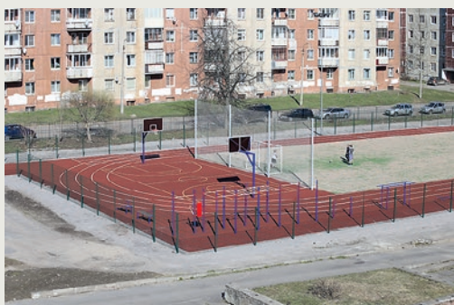
Стадион в г.Тихвин после капитального ремонта
