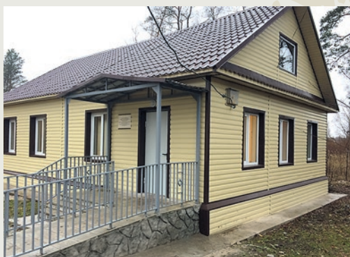
ФАП в пос. Черновский Сланцевского района после капитального ремонта
