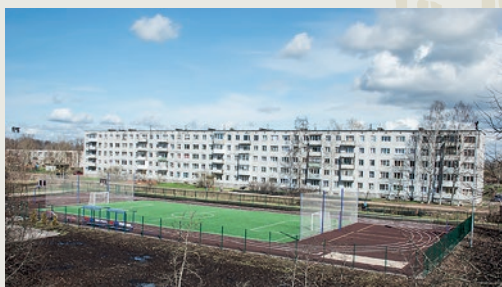
Спортивная площадка МБОУ «Ивангородская СОШ № 1 им. Н.П. Наумова» после капитального ремонта
