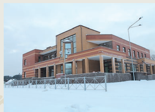
Строительство сельского дома культуры со зрительным залом на 150 мест и библиотекой в с. Алеховщина
