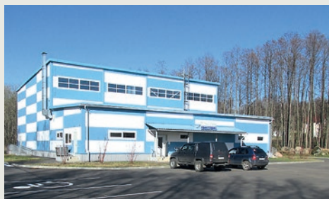
Строительство ФОКа в дер.Вистино Кингисеппского района
