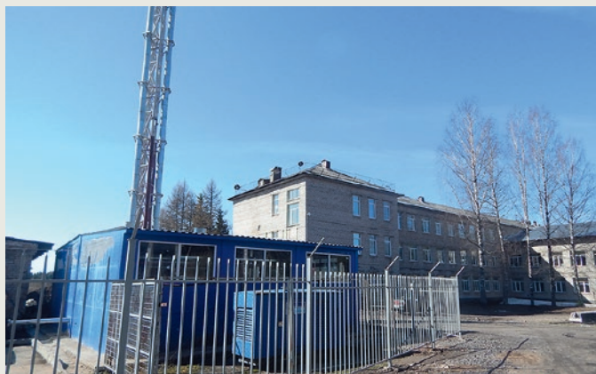
Газовая блочно-модульная котельная для ГКОУ ЛО «Ефимовская специальная (коррекционная) школа-интернат» в пос. Ефимовский
