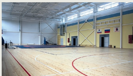
Строительство ФОКа ГБОУ ДОД «Детский оздоровительно образовательный центр «Россонь»
