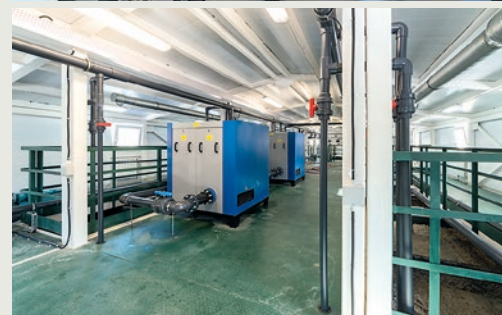
Строительство комплекса очистных сооружений в поселке Платформа 69 км Приозерского района
