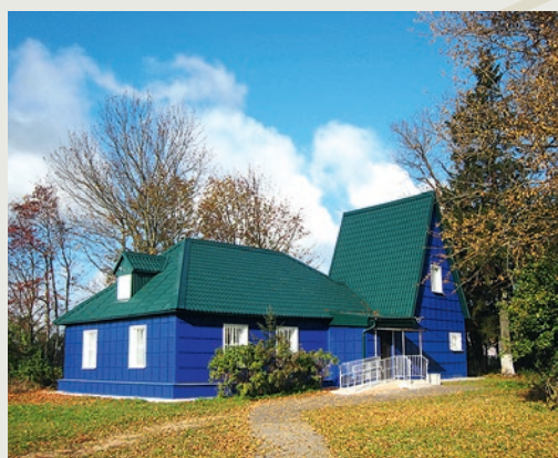
Историко-краеведческий музей в г. Волосово после капитального ремонта
