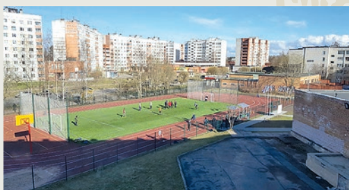
Спортивная площадка при СОШ №6 в г.Сосновый Бор после капитального ремонта
