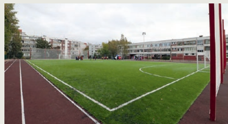
Стадион при средней общеобразовательной школе №8 в г.Выборге после капитального ремонта
