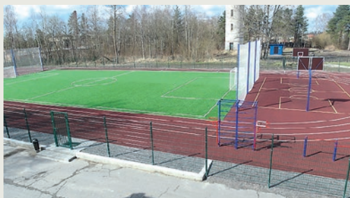
Спортивная площадка «Александрогорская основная общеобразовательная школа» Кингисеппского района после капитального ремонта
