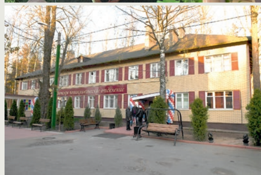
Каменногорская городская больница после ремонта
