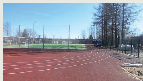
Строительство спортивной площадки в дер. Большой двор
